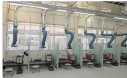
実習工場(溶接室)
